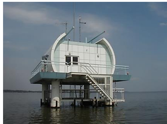
掛馬沖水質水位自動観測所
