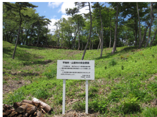
施工後の状況
