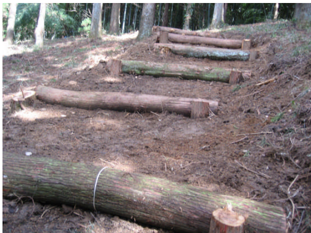
現場発生材を利用した階段
