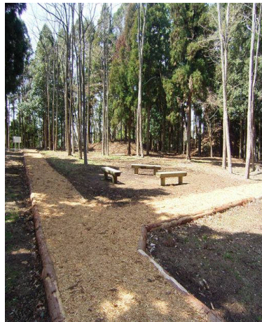
現場発生材を利用した散策路
