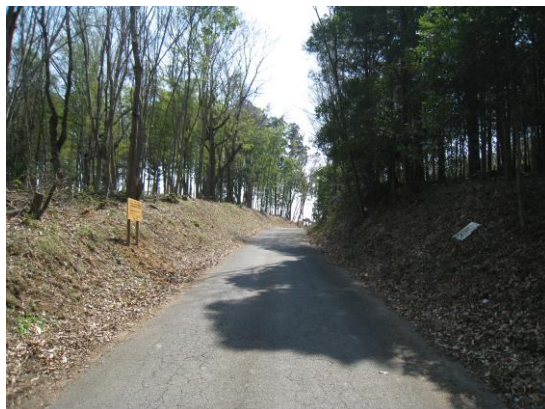
整備後の状況
