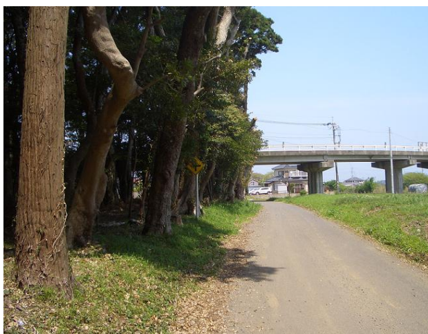
整備後の状況
