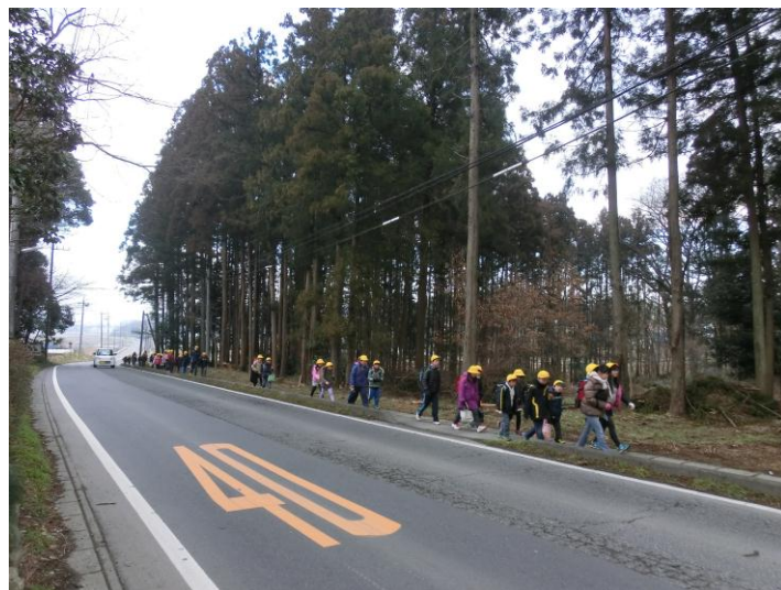
整備後の状況
