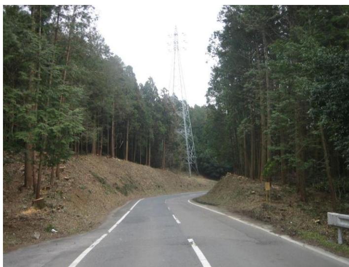
整備後の状況
