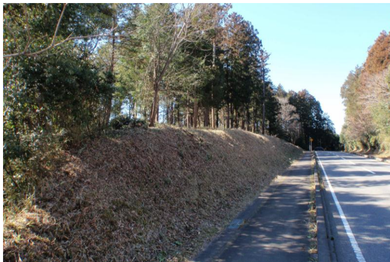
整備後の状況
