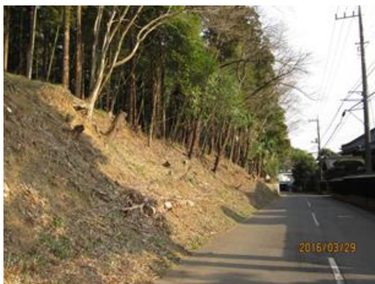
整備後の状況
