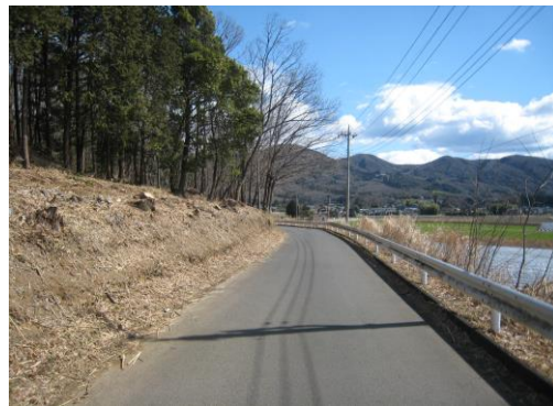
整備後の状況
