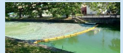
上: 船による撪拌 下: アオコフェンスの設置
