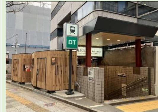
建築物の木質化 (昨年度竣工した駅舎)
