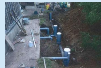
上：下水道接続工事 下：農業集落排水施設接続工事
