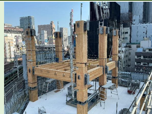
建築物の木造化 (昨年度竣工した木造ビル)
