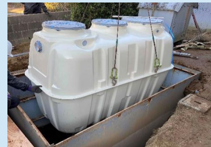
高度処理型浄化槽の設置
