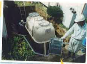
高度処理型浄化槽の設置補助
