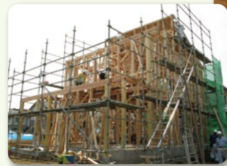
県産材を使った住宅の建築
