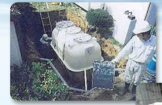
高度処理型浄化槽の設置
