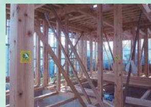
建築中の木造住宅
