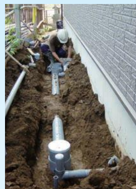
下水道接続工事
