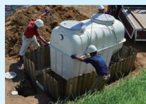
高度処理型浄化槽の設置
