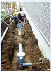
接続工事の様子
