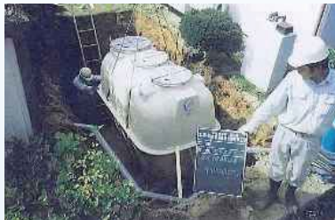
高度処理型浄化槽の設置
