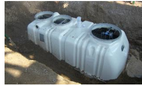
高度処理型浄化槽の設置
