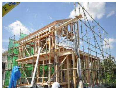
県産木材を使用した木造住宅 (つくば市)
