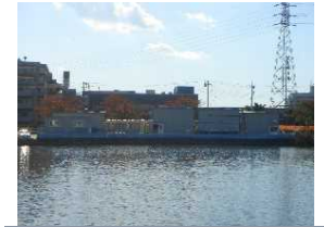
直接浄化施設(土浦市)
