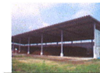
家畜排せつ物堆肥化施設
