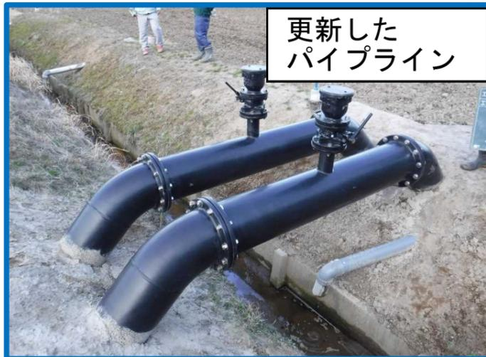
老朽化した用水路(パイプライン)の更新工事を行い、担い手農家の規模拡大に必要な生産基盤を整備。
