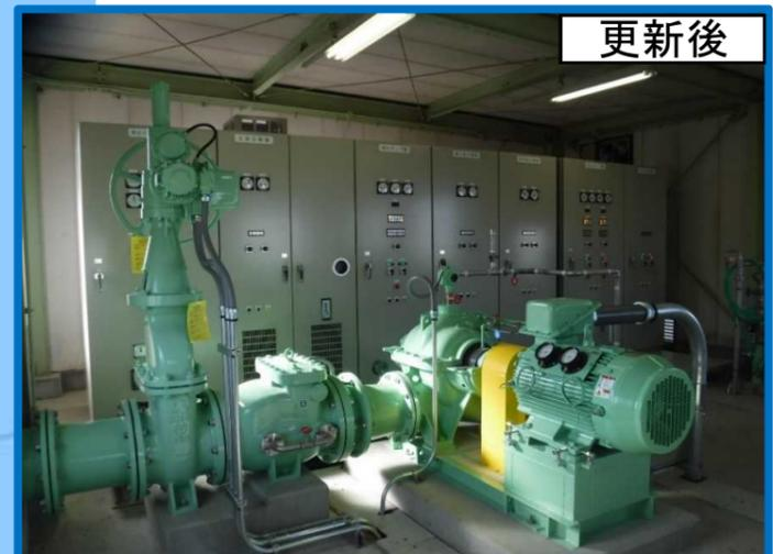
故障が頻発して維持管理に多大な労力を費やしている用水機場のポンプ設備の更新工事を行い、安定的な用水の供給を実現。
