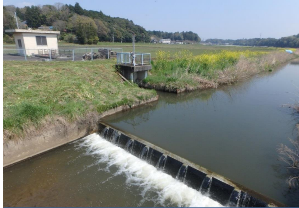
1級河川 梶無川からの取水
