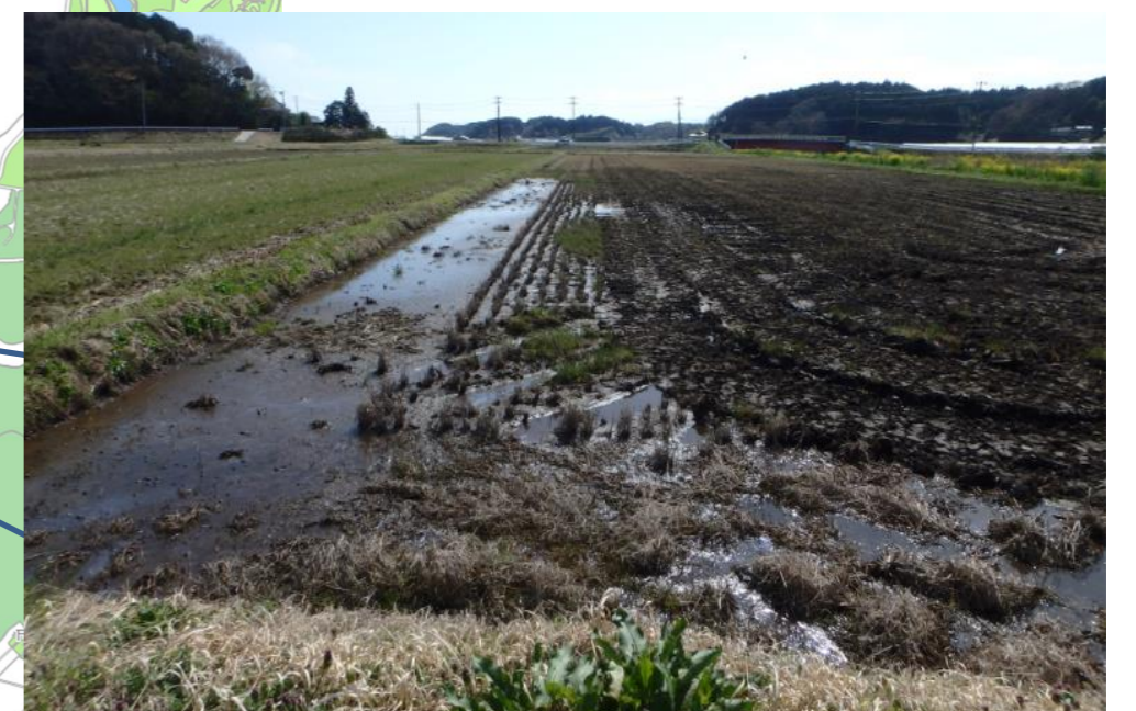
排水不良による水田の湛水状況
