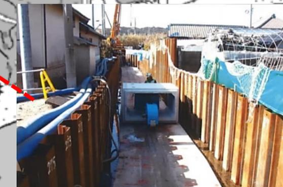
リフトローラ工法によるボックスカルバート設置 (平成25年度)
