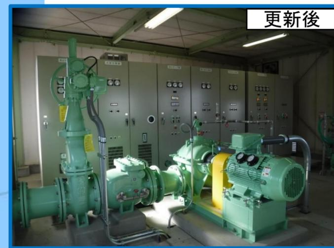
故障が頻発して維持管理に多大な労力を費やしている用水機場のポンプ設備の更新工事を行い、安定的な用水の供給を実現。
