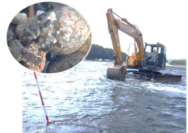
重機を活用したアユの産卵場造成
