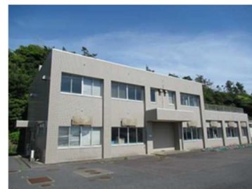
水産加工実験棟
