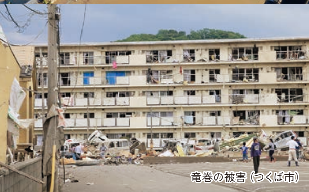
令和元年 東日本台風での被害（水戸市）
