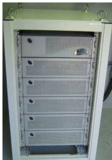
無停電電源装置
