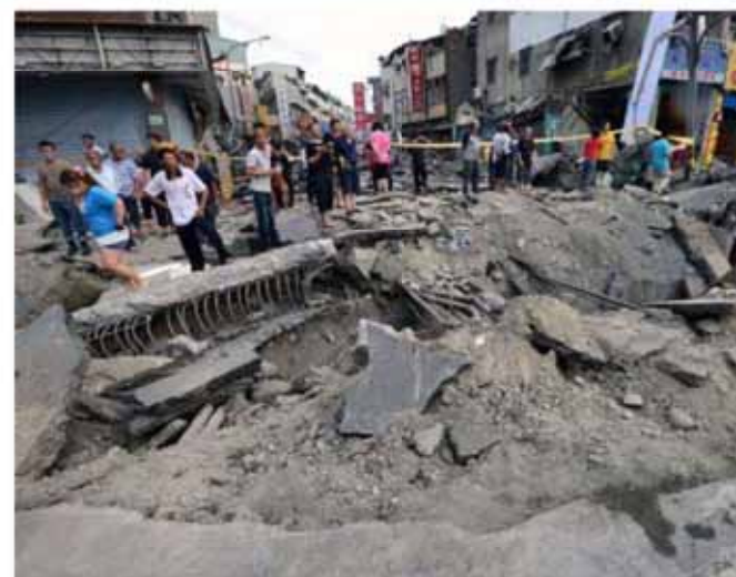
ガス爆発現場の状況
