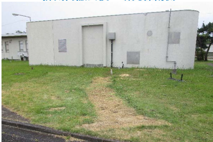
排気筒撤去後の研究棟南側
