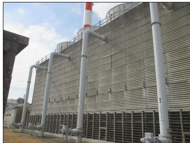
冷却塔倒壊前(H30.2.16撮影)
