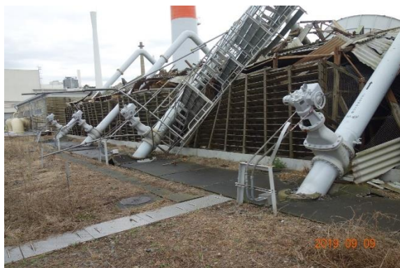
冷却塔倒壊後 東側
