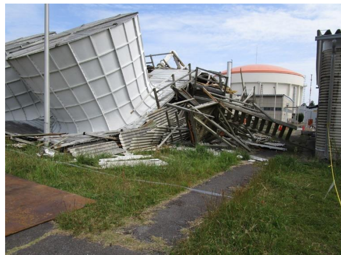
撤去前状況(南側) (令和元年10月7日撮影)
