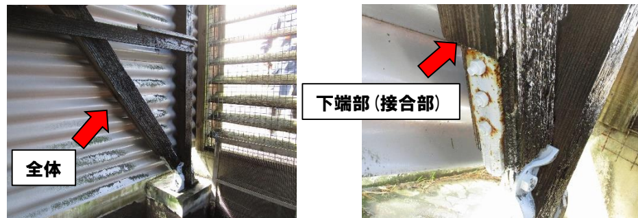
(c) 針貫入試験において針貫入深さが最大となった箇所(5/E~F)
