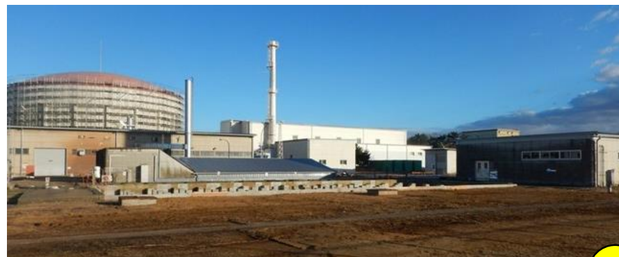
撤去後状況(西側)(令和2年1月31日撮影)
