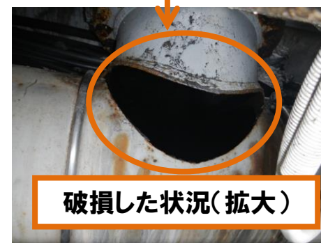
二次冷却系配管立ち上がり部の破損
