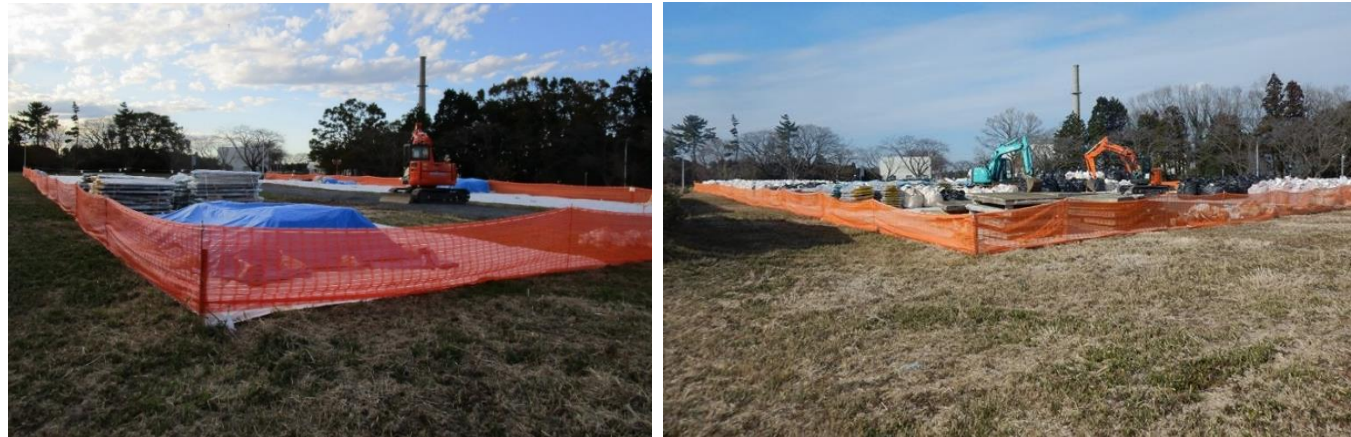
がれき等の保管場所の状況 (左:令和元年11月14日撮影、右:令和2年2月3日撮影)
