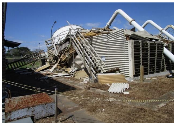
冷却塔倒壊後 南側
