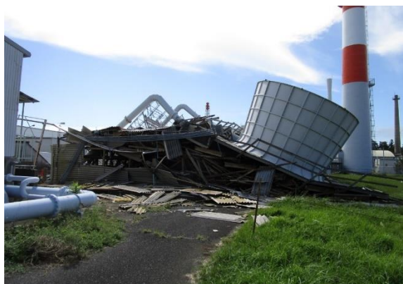
冷却塔倒壊後 北側
