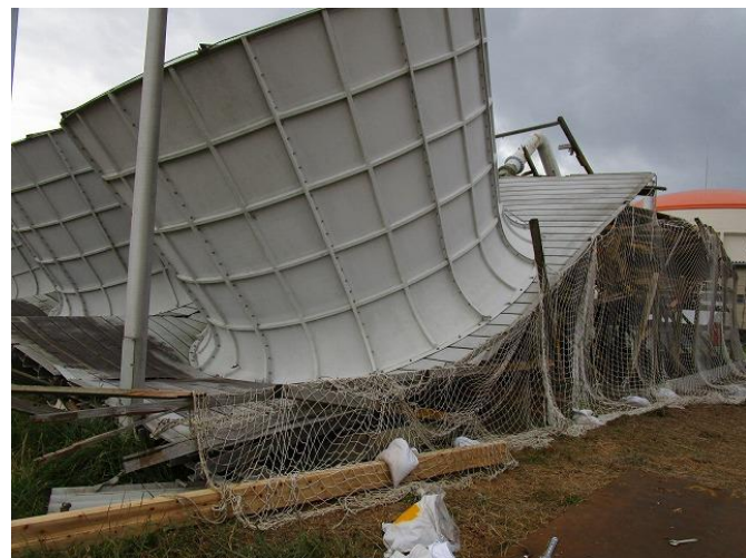
撤去中状況(南側) (令和元年10月24日撮影)
