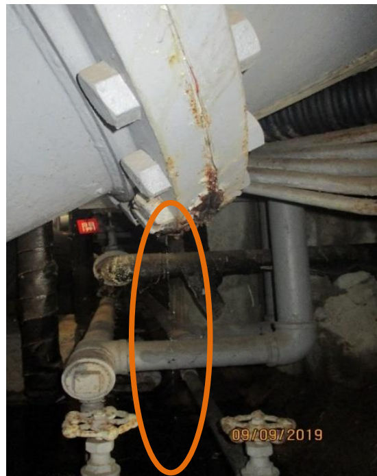
二次冷却系配管 止水前
