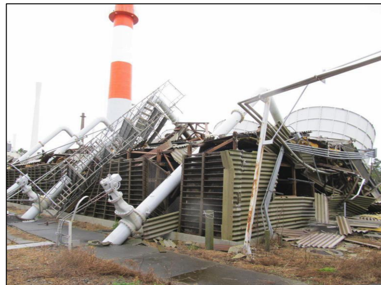
冷却塔倒壊後(R1.9.9撮影)
