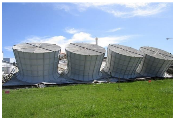
冷却塔倒壊後 西側
