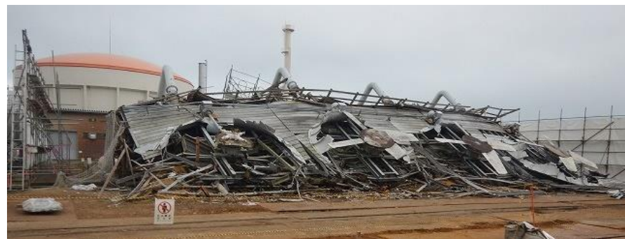
撤去中状況(西側)(令和元年12月11日撮影)
