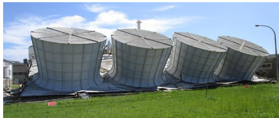
撤去前状況(西側)(令和元年9月12日撮影)
