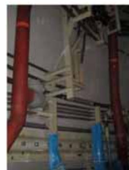
仮設足場組立前
