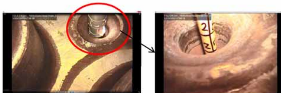
目視試験の様子
