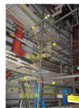
仮設足場組立後
