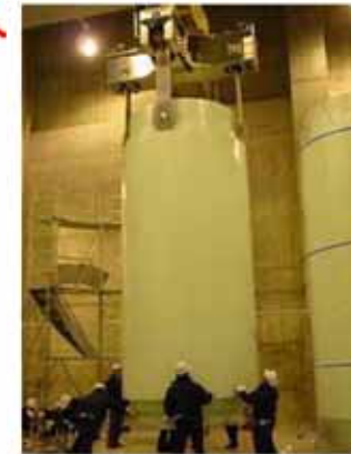
⑤ 乾式キャスクの移動作業
