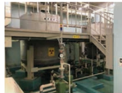
廃水貯槽及び堰
