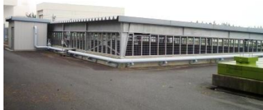
排水貯留ポンド
