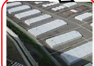
保管廃棄施設・M-2
