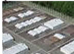
保管廃棄施設・M-1
