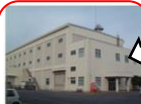
第2廃棄物処理棟
