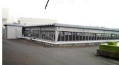
排水貯留ポンド
