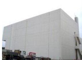
解体分別保管棟
