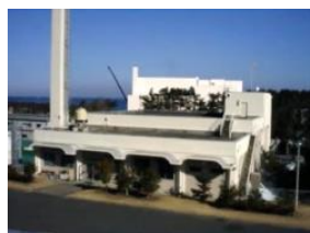
第1廃棄物処理棟
