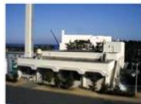
第1廃棄物処理棟
