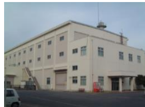
第2廃棄物処理棟
