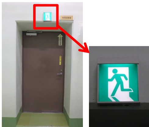
誘導灯(避難口)
