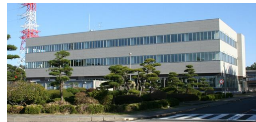
緊急時対策所
