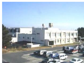
第3廃棄物処理棟
