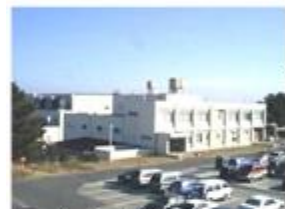
第3廃棄物処理棟
