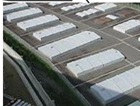
保管廃棄施設・M-2
