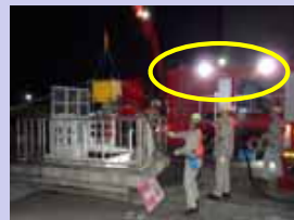
暗所環境下での可搬型代替注水ポンプ車の設置・運用
