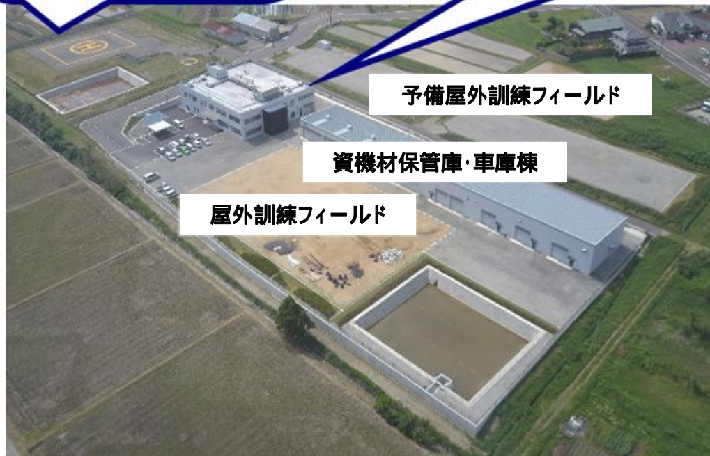
美浜原子力緊急事態支援センター拠点施設の全景
