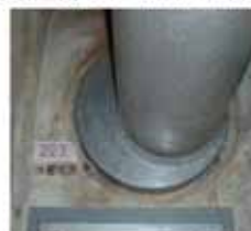
貫通部の止水処置(例)
