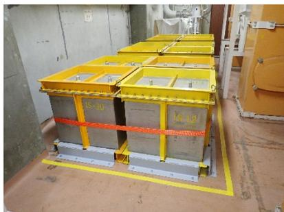
ヨウ素フィルタ保管容器の連結・床面への固定
