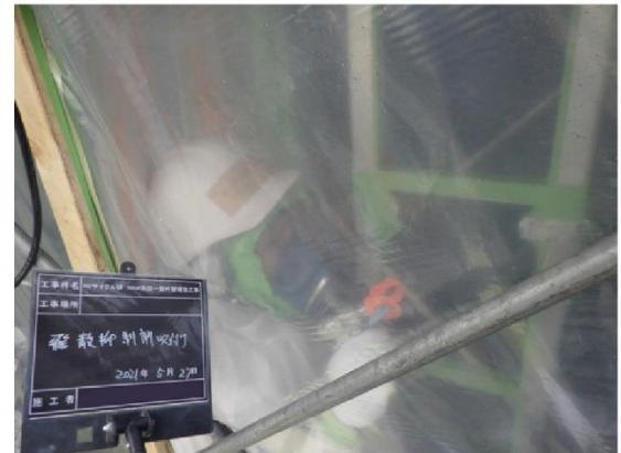
[アスベスト除去作業]
