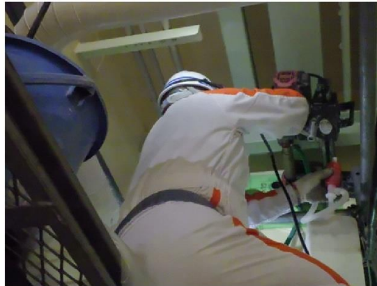
[壁のコア抜き調査]
