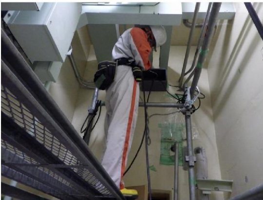
[工事エリア周辺の電線管等の移設作業]
