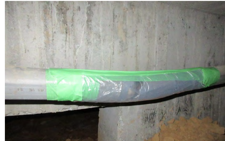
図5-1 破断箇所Aの養生
