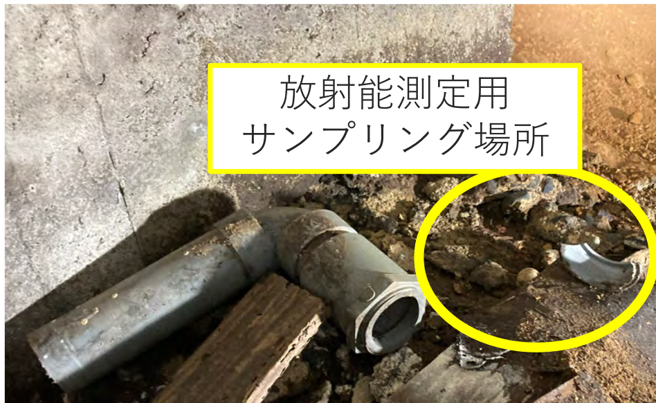
図7-7 脱落箇所B直下の土壌
