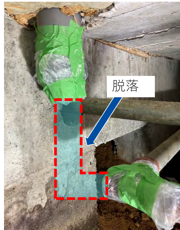
図5-3 脱落箇所Bの養生
