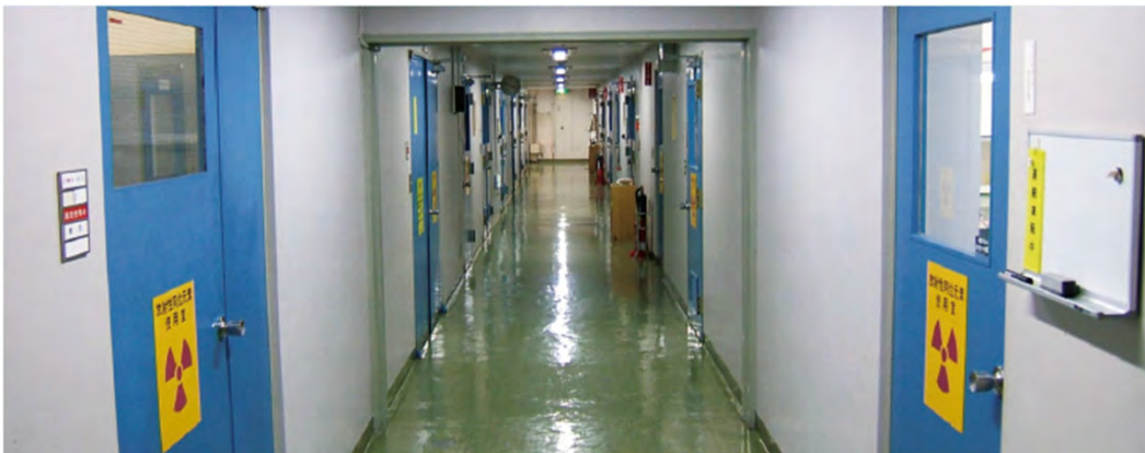
図2-2 第一実験棟屋内
