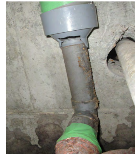
図5-2 脱落箇所Bの仮養生
