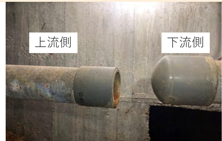
図10-2 破断箇所A排水管系切り離し箇所
