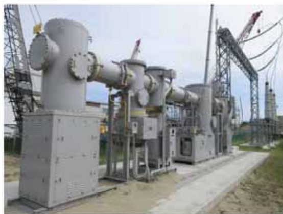
ガス絶縁開閉装置への設備変更
