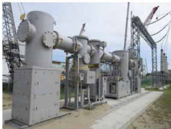
ガス絶縁開閉装置への設備変更
