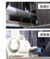
排風機及び風速計設置状況
