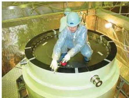
② 原子炉建屋除染ピットでの一次蓋ボルト締め付け作業
