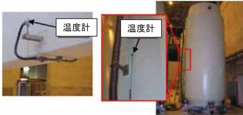
給排気口温度及び貯蔵容器表面温度
