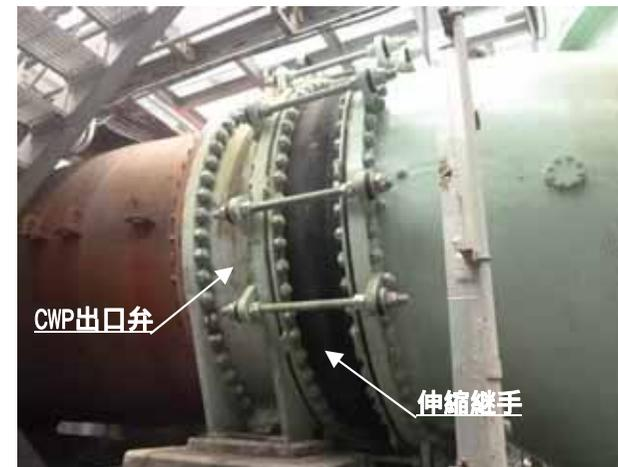
図6.16 循環水ポンプ出口管及び伸縮継手
