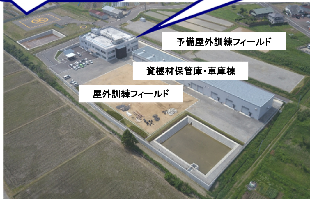
美浜原子力緊急事態支援センター拠点施設の全景 緊急体制-60
