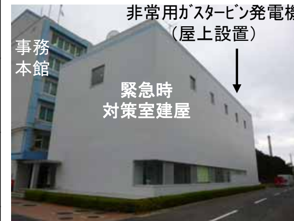
緊急時対策室建屋 (当時施工中)*
