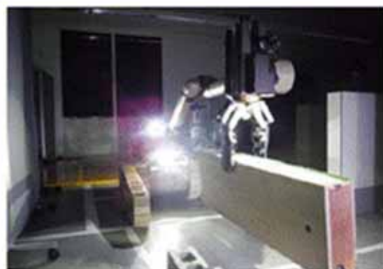
暗闇での障害物撤去
