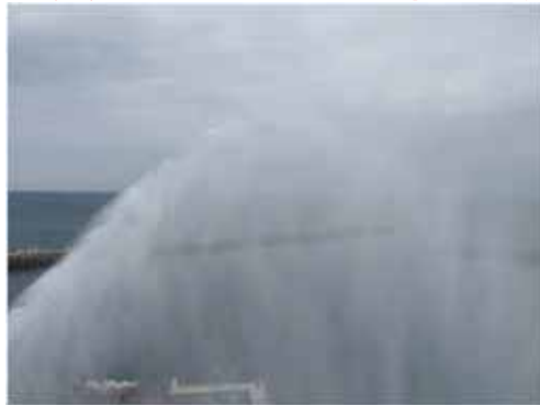
発電所で実施した放水試験 直状放射による放水(到達点での状態)
