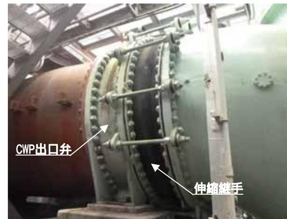
図6.16 循環水ポンプ出口管及び伸縮継手
