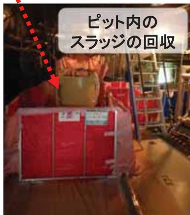
図1 ペDESTAL内既存設備の移動・除染作業 格納容器冷却-55
