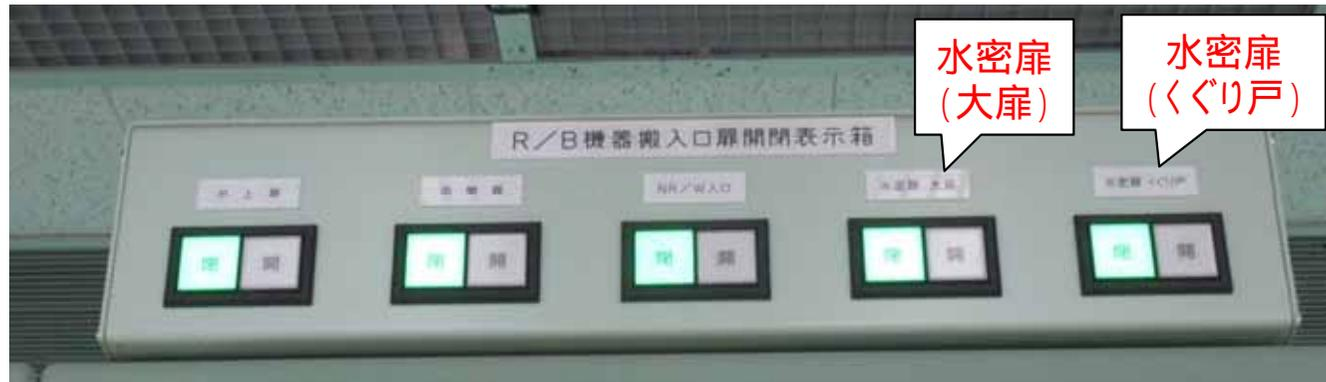
図1 原子炉建屋機器搬入口水密扉の開閉表示灯(中央制御室)
