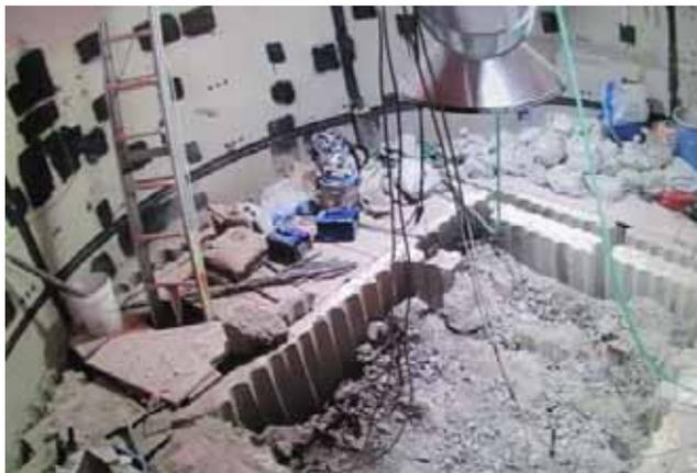
図2 既存床コンクリートはつり作業
