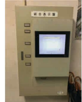
運転表示盤(19箇所)
