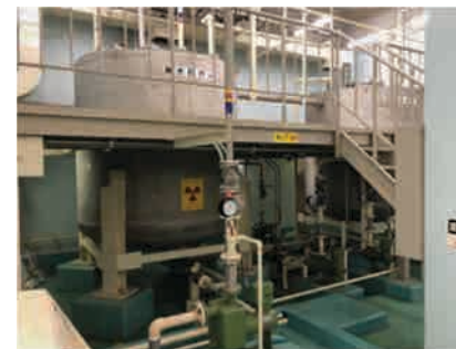
廃水貯槽及び堰
