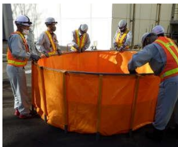
組立式水槽の設置
