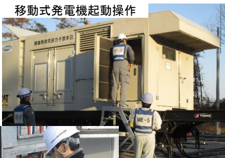
移動式発電機起動操作
