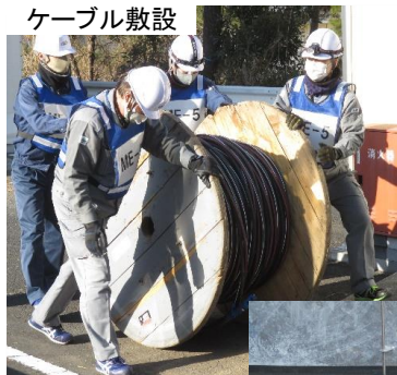
ケーブル敷設
