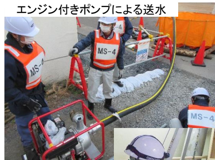
エンジン付きポンプによる送水
