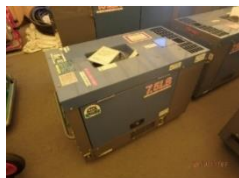
⑦可搬型発電機
