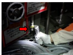
⑥仮設ホース接続
