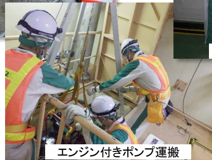
エンジン付きポンプ運搬
