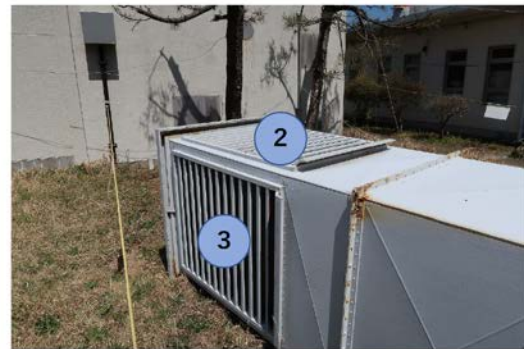
排気筒 ガラリ外側
