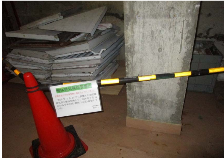
解体した排気筒の保管場所の状況。ホットラボ実験棟放射線管理区域内に区画して保管した。 (令和2年6月23日撮影)
