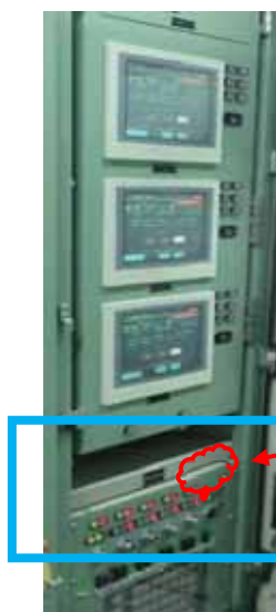
当該制御盤外観（外扉内）
