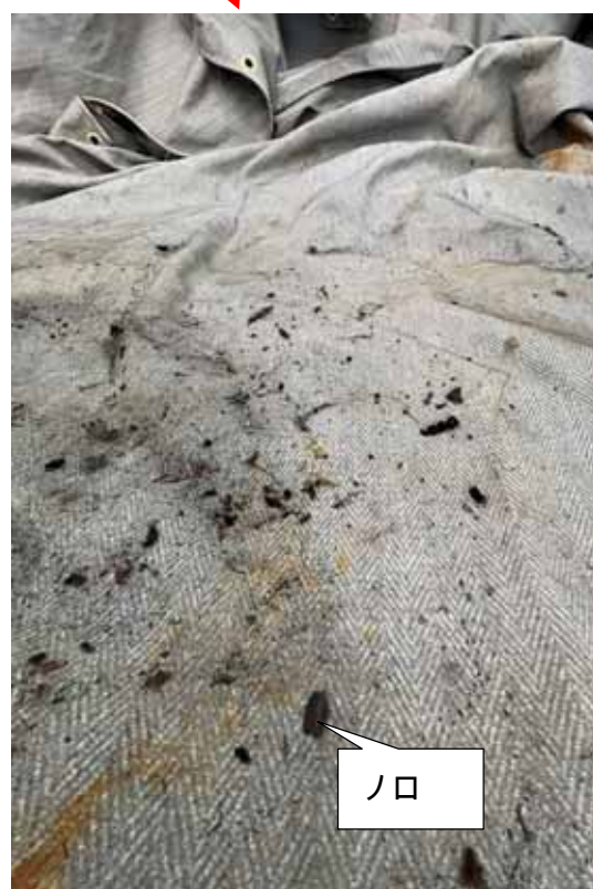
下部火気養生状況
