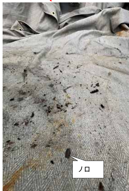
下部火気養生状況
