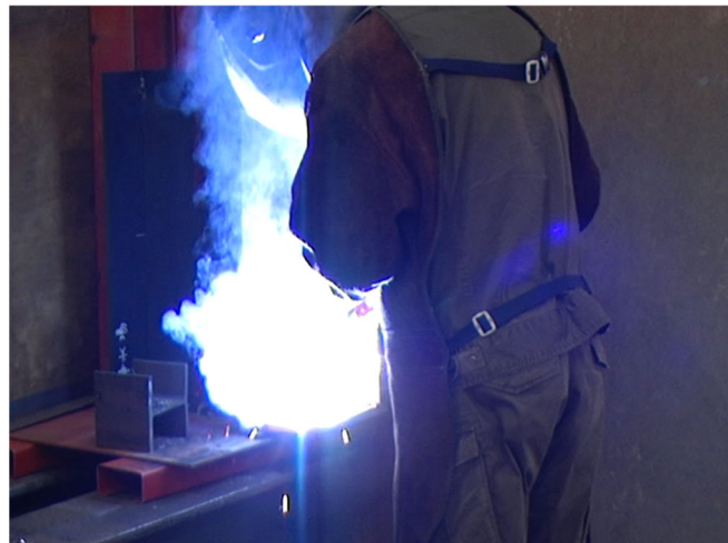
直線溶接状況写真（隙間からの火花飛散なし）
