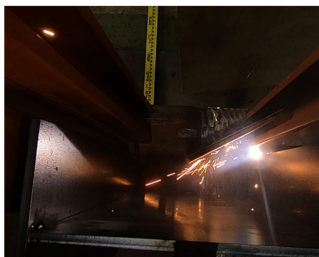
合板①端部溶接状況写真 （隙間からの火花飛散なし）
