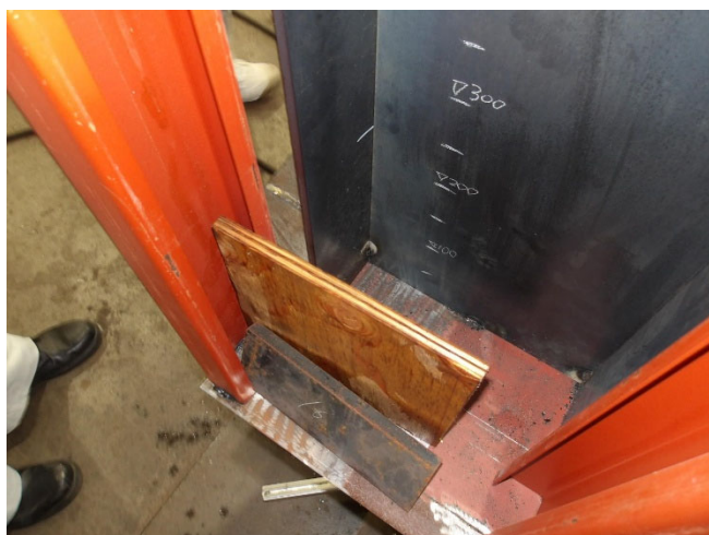
合板②設置写真
