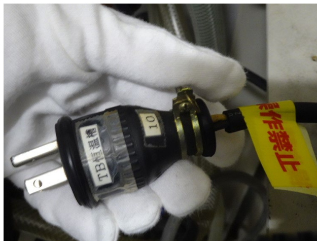
写真 4-2 発災した恒温槽の主電源のコンセント引抜の状況
