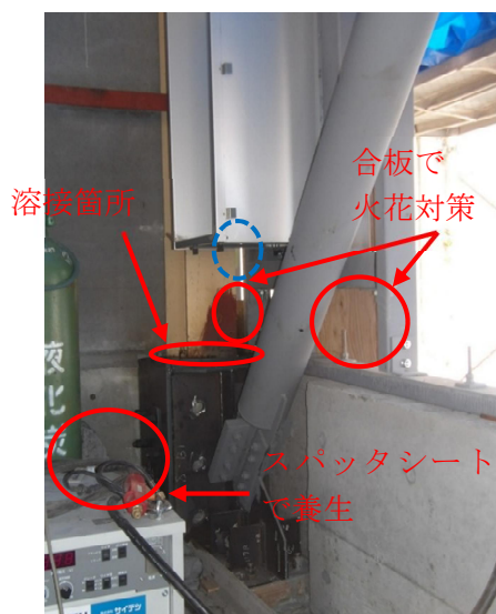
溶接箇所（屋内）
