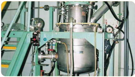
▲事故を起こした核燃料加工施設の沈 しず でん槽
