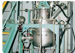
事故を起こした ウラン加工施設の沈でん槽
